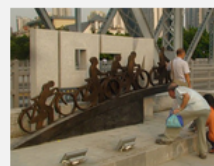
海珠桥主桥今开放参观
